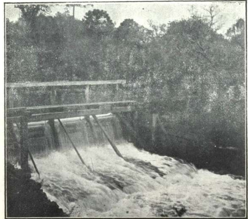
A queda de agua que fornece força motriz á fabrica
