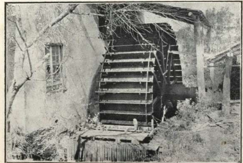
A roda accionadora dos machinismos e que desenvolve força de 30 cavallos
